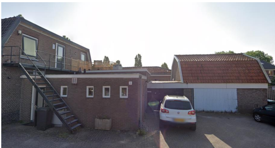
Afbeelding 15. Achterzijde met aanbouw en schuur.
