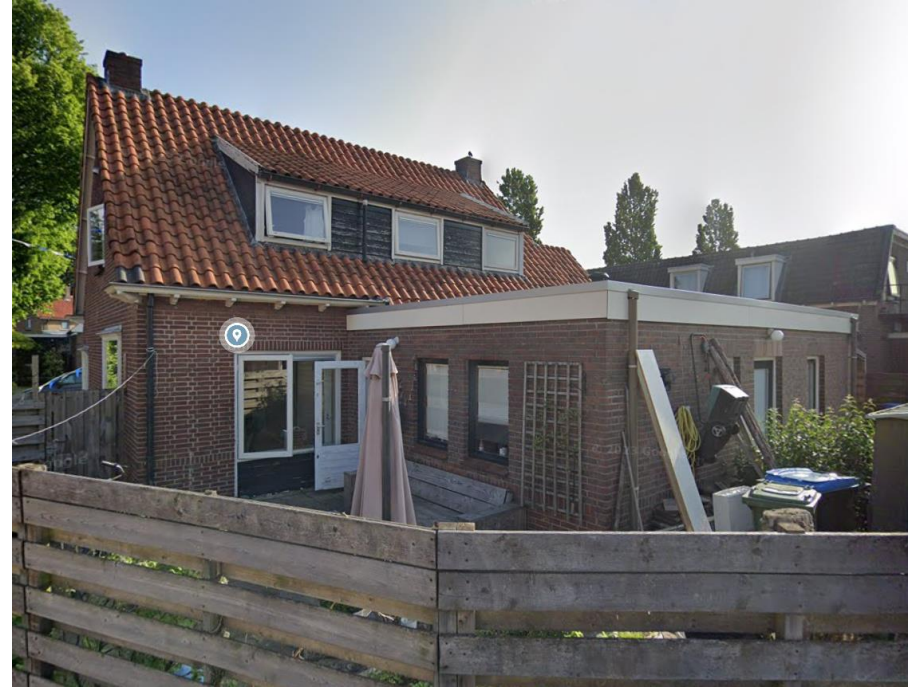
Afbeelding 19. Achterzijde met latere aanbouw.
