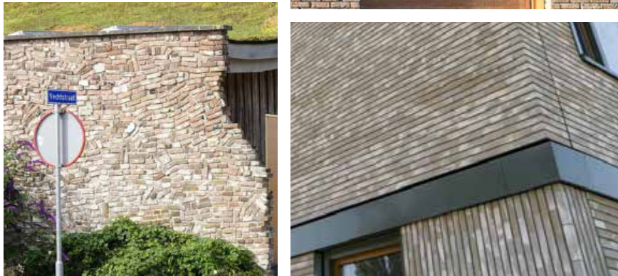
Hergebruik materialen, hier als aanleiding voor speciaal metselverband
