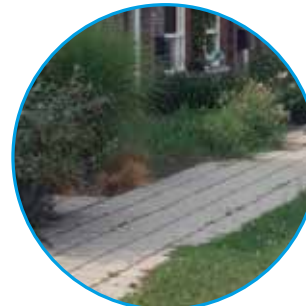
Voetpad Nieuwenhuisstraat (tegels)
