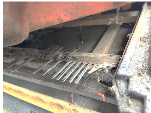
Figuur 19. Dakrand van de boerderijwinkel met opgelichte pan en vogelschroot.
