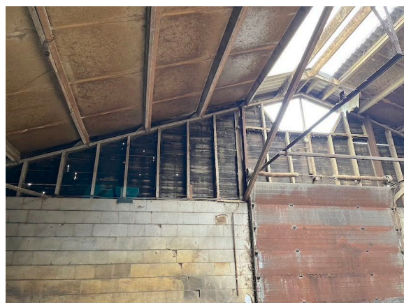
Figuur 15. Binnenzijde kopgevel stal met gasbetonblokken en houtenschroten.
