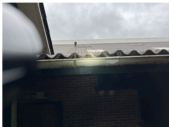
Figuur 16. Buitenzijde dak stal met vogelschroot in de dakrand.
