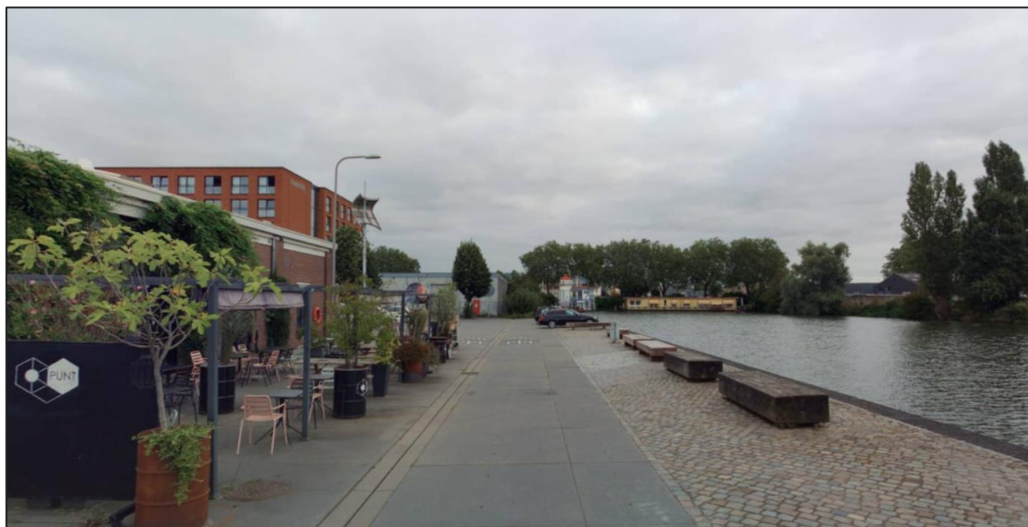
Afbeelding 3.3: Lijngoten in bestaande kade Scheepvaartstraat (bron: Streetsmart)
