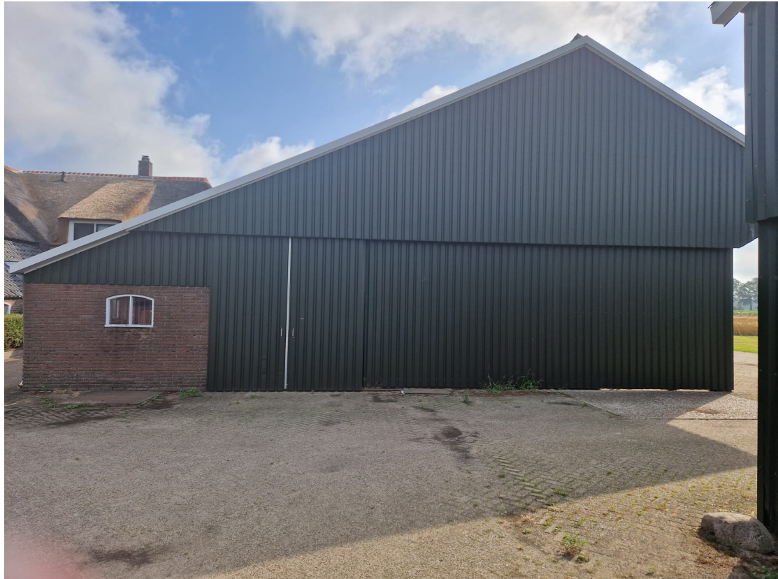
Erf zijde bestaande kapschuur
