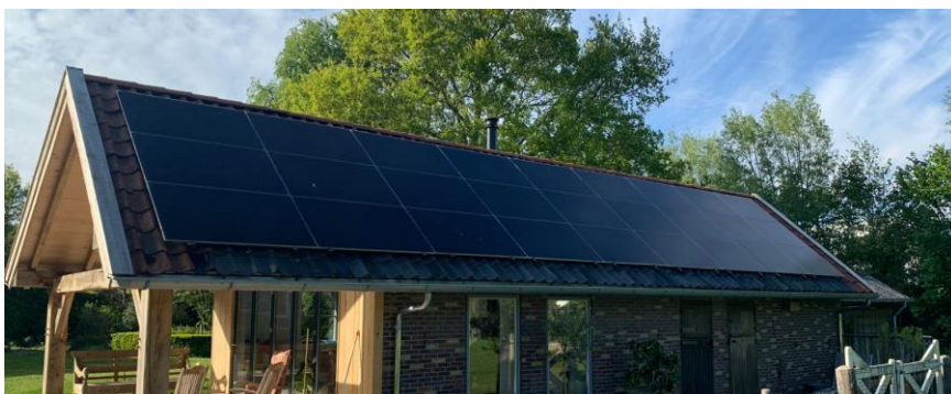
Benut het zongerichte dakvlak voor plaatsing van zonnepanelen
