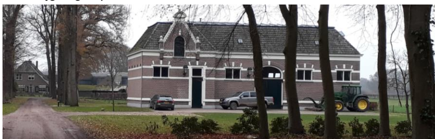
Huidige parkeerruimte achter het Koetshuis
