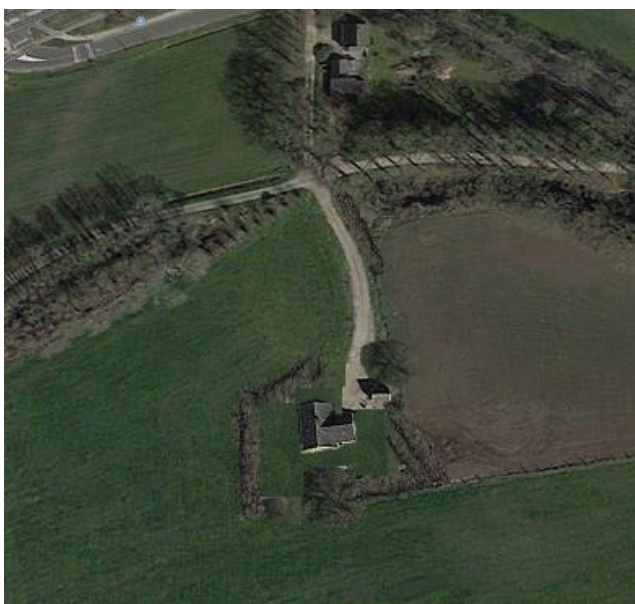
Situatie na sloop en herbouw
