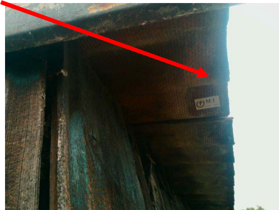
Foto 4 | Golfplaten op het dak
