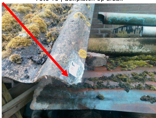
Foto 15 | Golfplaten op afdak
