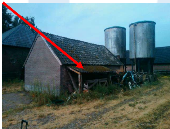
Foto 13 | Golfplaten op afdak
