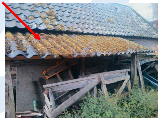
Foto 14 | Golfplaten op afdak
