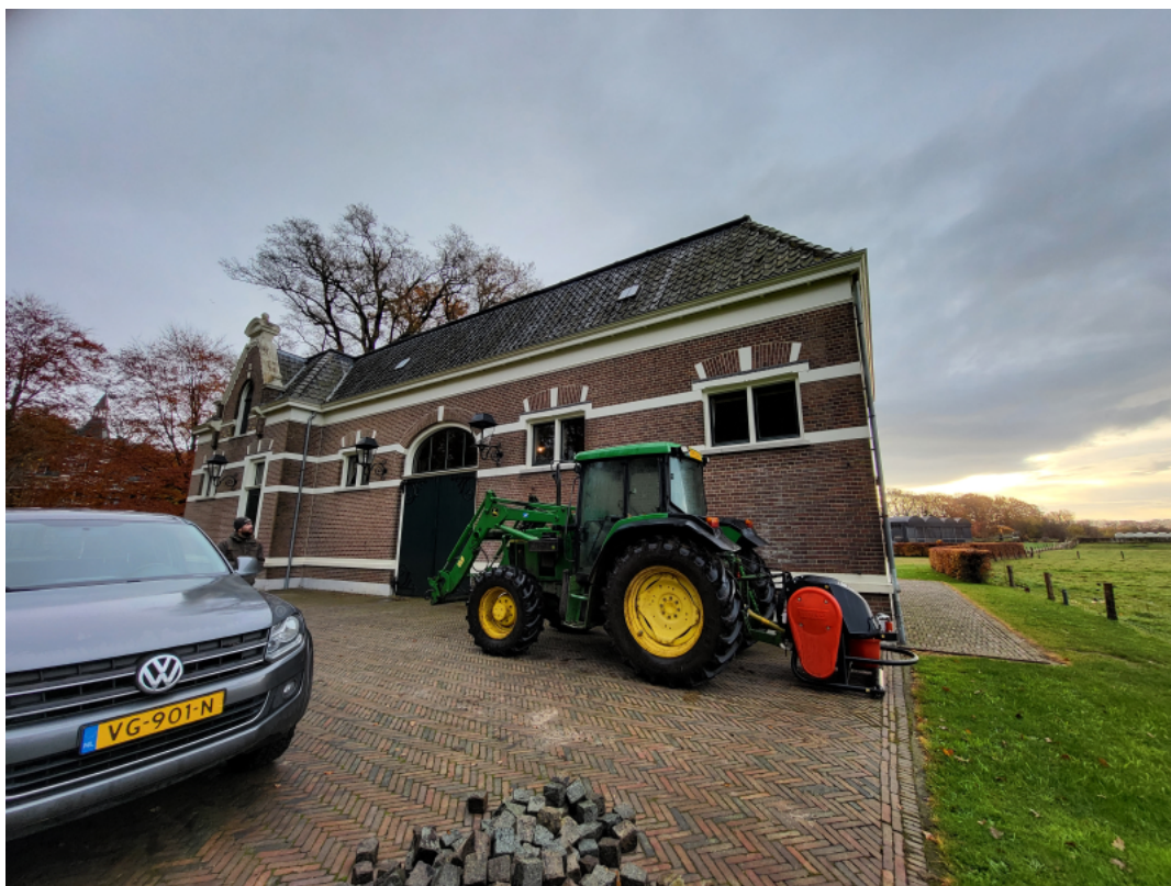
Foto 14 Omschrijving Buiten: Voorgevel
