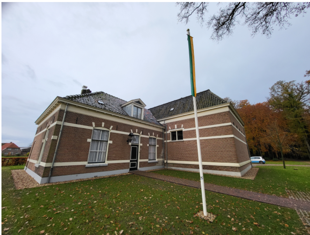
Foto 17 Omschrijving Buiten: Woning
