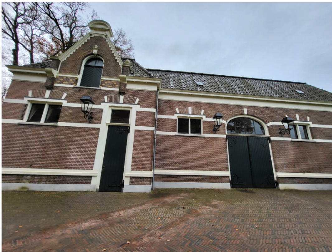
Foto 13 Omschrijving Buiten: Voorgevel
