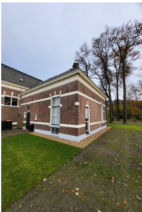
Foto 15 Omschrijving Buiten: Achtergevel
