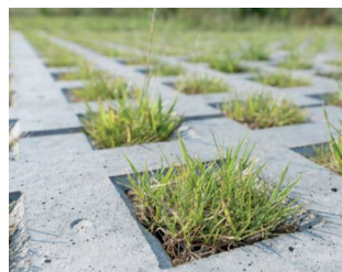
1.5. Parkeren (park), grasbetonverharding
