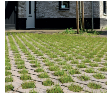
7.8. Groen parkeren op grasbetonverharding - MBI De Steenmeesters
