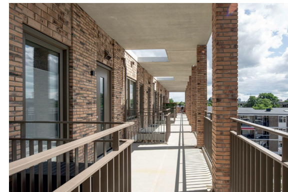
4.1.a. Voorbeeld van een leefgalerij: ruimte voor de woning om een stoel en tafel te plaatsen ligt los van de vluchtroute - LEVS architecten
