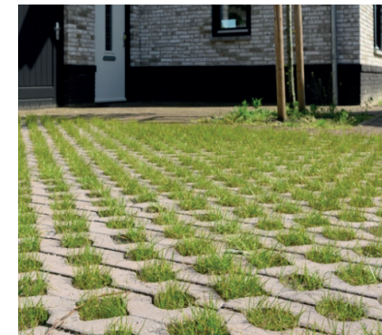
7.8. Groen parkeren op grasbetonverharding - MBI De Steenmeesters
