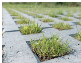
1.5. Parkeren (park), grasbetonverharding
