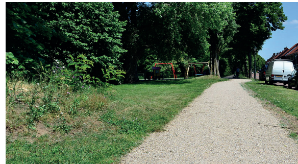
7.7. Paden in halfverharding in het park
