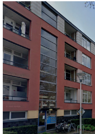
Bestaande bouw: portiek als verticaal onderdeel aan de Lebuïnuslaan
