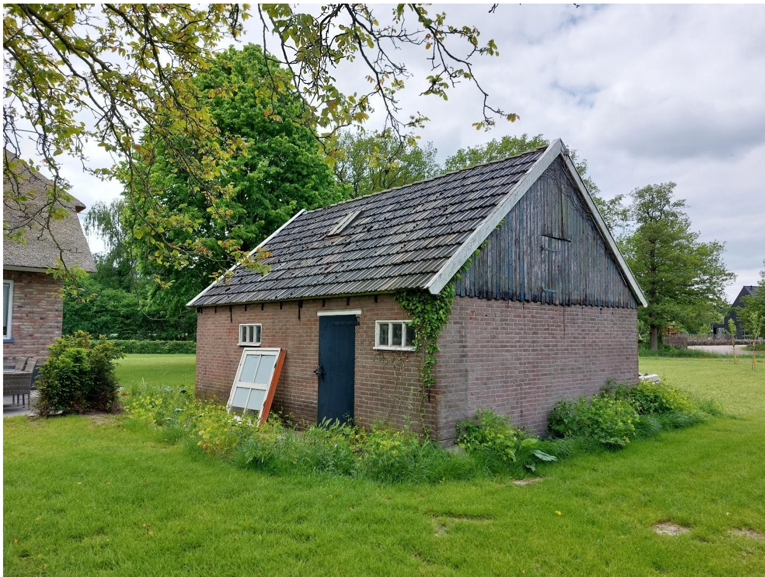
Afbeelding 6: Te verwijderen schuur, situatie op 25 mei 2023.
