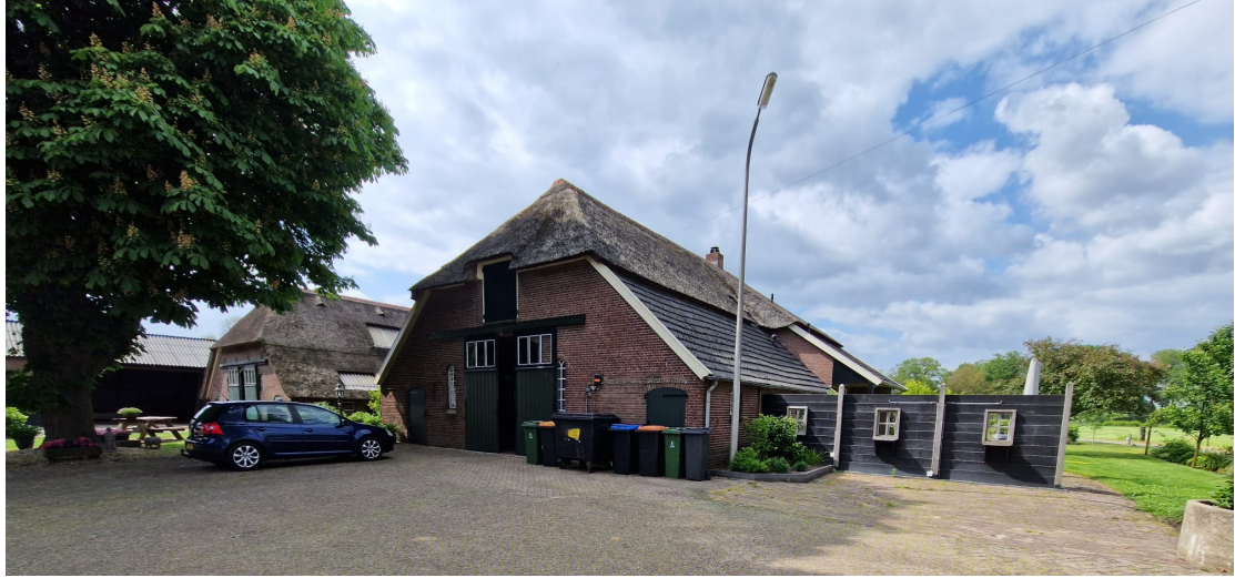
Figuur 3 Achterzijde boerderij en bijgebouw
