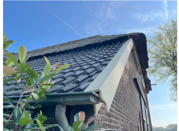
Figuur 4. Achterzijde hoofdwoning (de deel) van gebouw 1.
