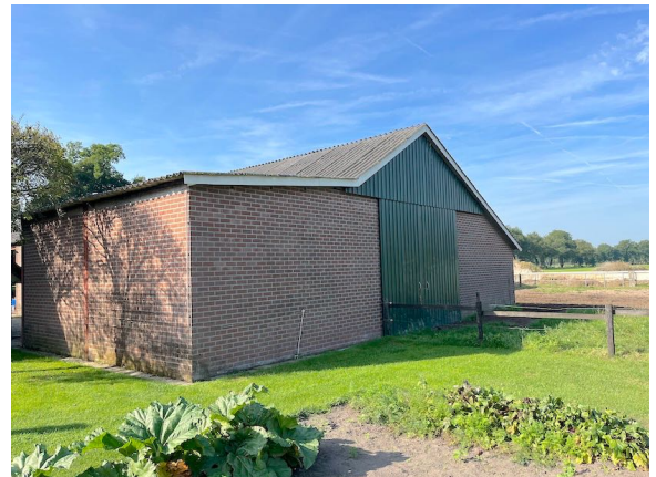
Figuur 6. Noordzijde kapschuur (nr. 3).
