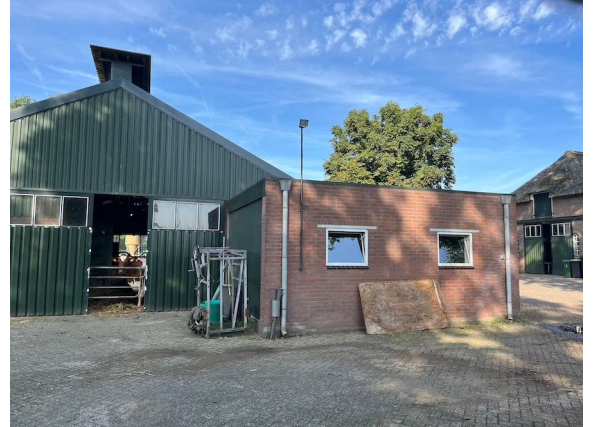
Figuur 10. Oostgevel stal (nr. 4).
