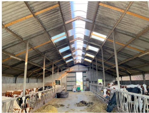
Figuur 24. Afgesloten dakrand van de stal.
