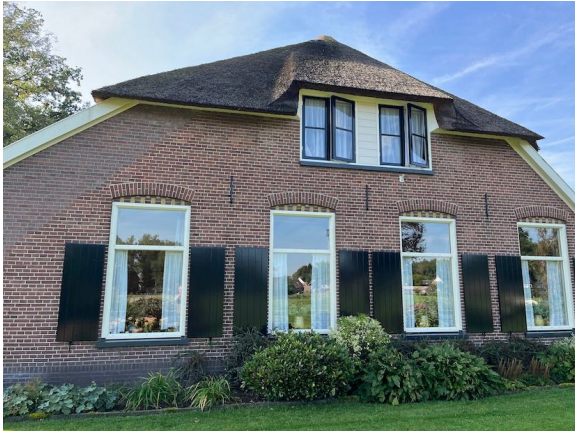
Figuur 3. Noordzijde hoofdwoning gebouw 1.
