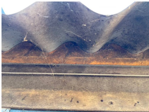
Figuur 26. Afgesloten dakrand van de stal.
