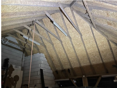
Figuur 20. Zolder van de deel met osb-platen onder het riet.
