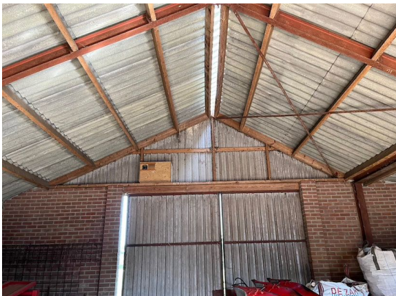
Figuur 7. Binnenzijde noordwesthoek kapschuur (nr. 3).
