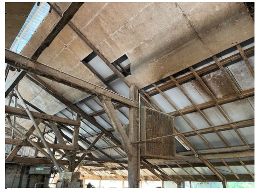
Figuur 25. Te slopen oostelijke deel van de stal met deels verdwenen piepschuimplaten en hierboven beschotplaten.
