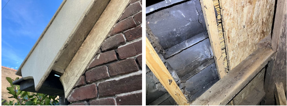
Figuur 18 & 19. Links windveer van de deel (nr. 1), rechts binnenzijde dak van de deel met overgang van pannen naar riet (op osb-plaat).
