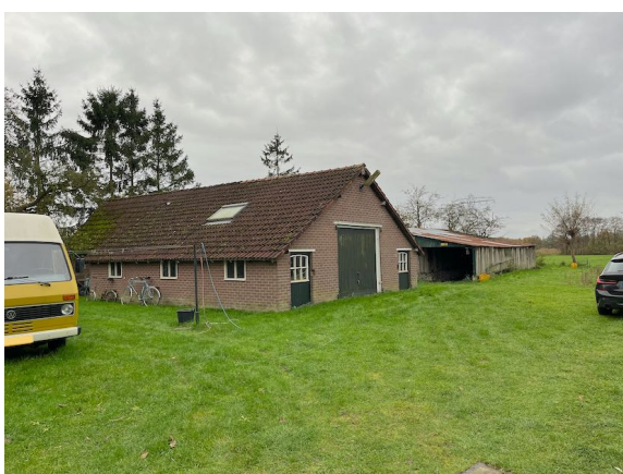
Figuur 5. Schuur/garage (nr. 2) naast de woning.
