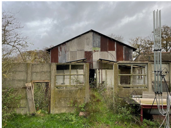
Figuur 9. Restanten stal naast de kapschuur met op de achtergrond de kapschuur.
