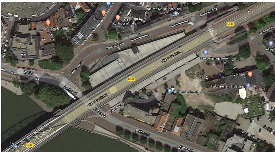
Foto 1: Ligging van de Brinkgarage onder en naast de Rijksweg/N344 (foto: Google Maps)
